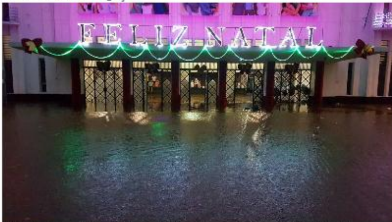
Estação Ferroviária de Bauru foi invadida pelas águas: "nada feliz"
