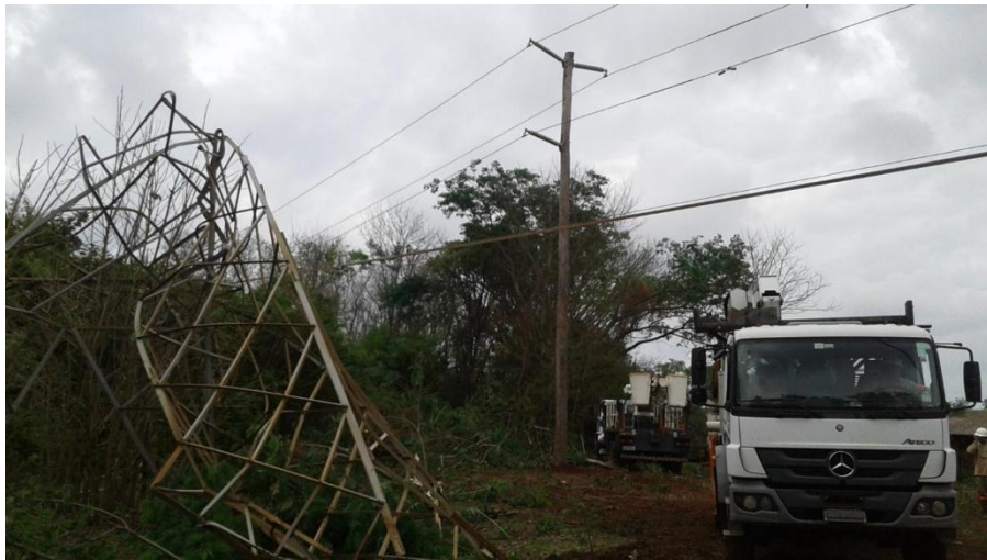
Figura 11 - Registro Fotográfico – Quedas de torres de transmissão da CPFL Paulista
