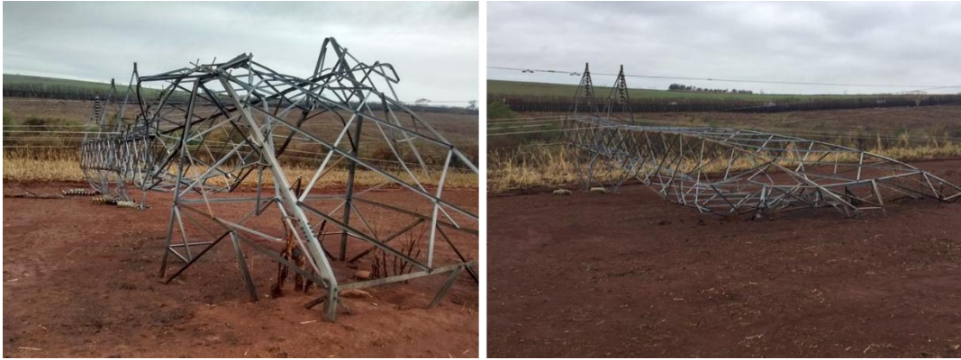
Figura 10 - Registro Fotográfico – Quedas de torres de transmissão da CPFL Paulista
