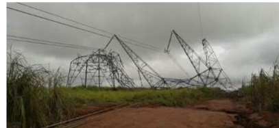
Figura 22 - Torres de transmissão destruídas pela força do temporal
