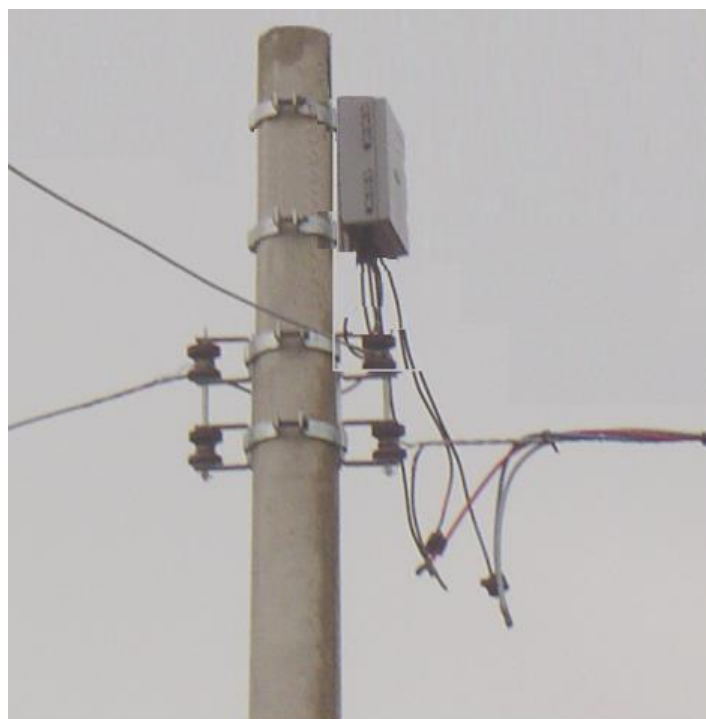
Figura 6 – Instalação da Caixa de Distribuição de Ramais (CDR).
