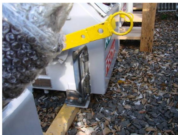
Figura 3 - Chave a óleo com fechamento para baixo, com a trava instalada
